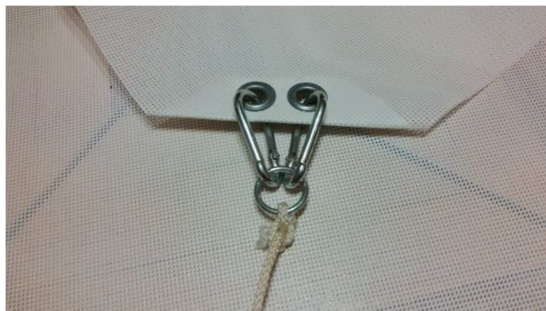
Rys 1. Poprawne mocowanie żagla
